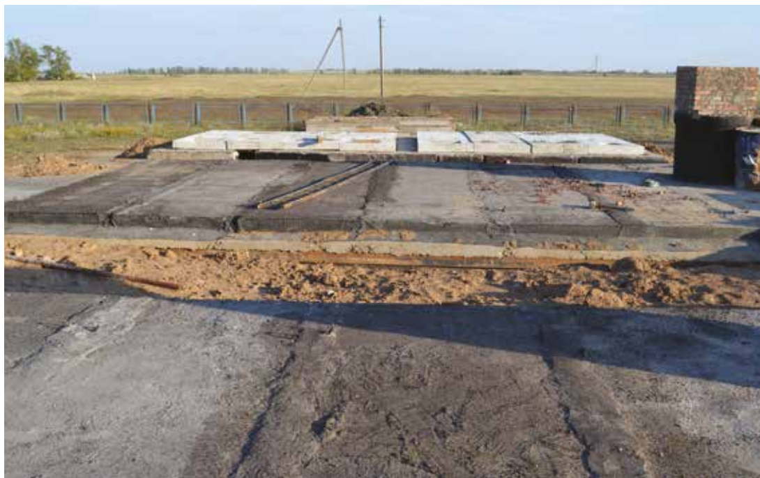
До начала работ
