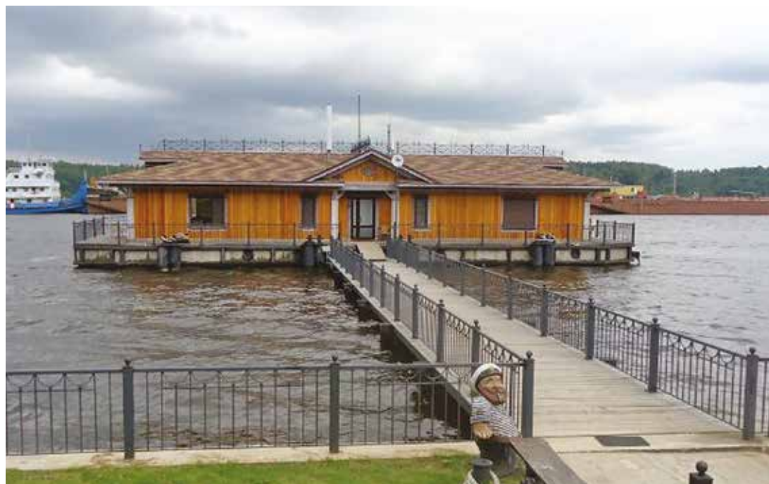
До начала работ
